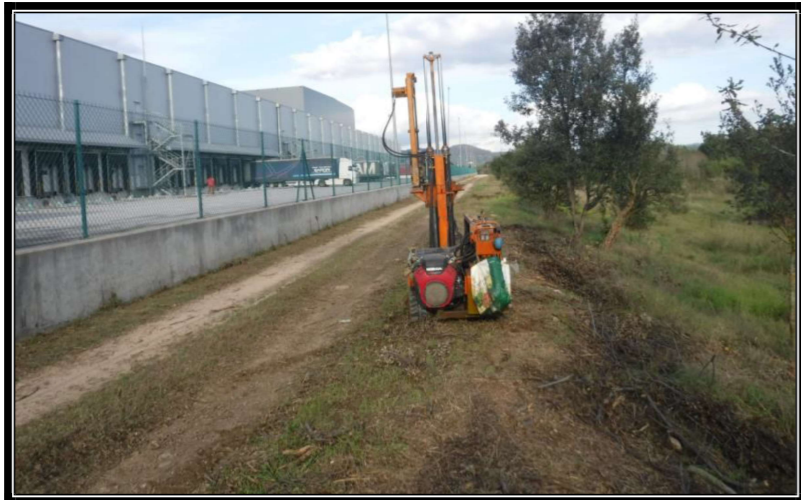
Màquina emplaçada a un dels punts i aspecte del camí lateral.
